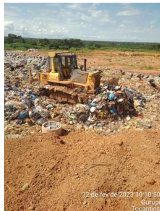
Figura 14 ESPALHAMENTO E COBERTURA DOS RESÍDUOS SÓLIDOS
