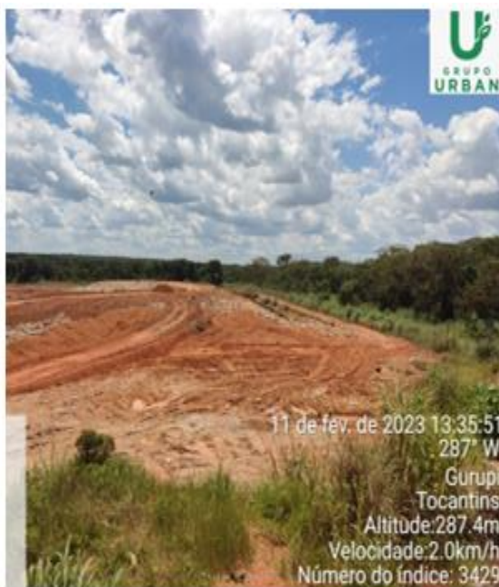
Figura 1 COBERTURA E COMPACTAÇÃO DOS RESÍDUOS SÓLIDOS
